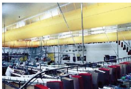
Figure 4. Différents dispositifs d'introduction d'air de compensation
