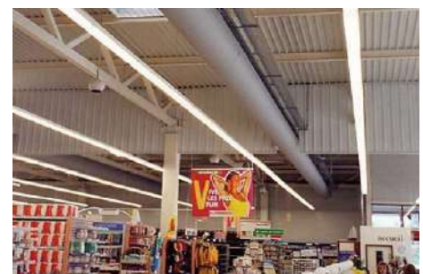
Figure 4. Différents dispositifs d'introduction d'air de compensation
